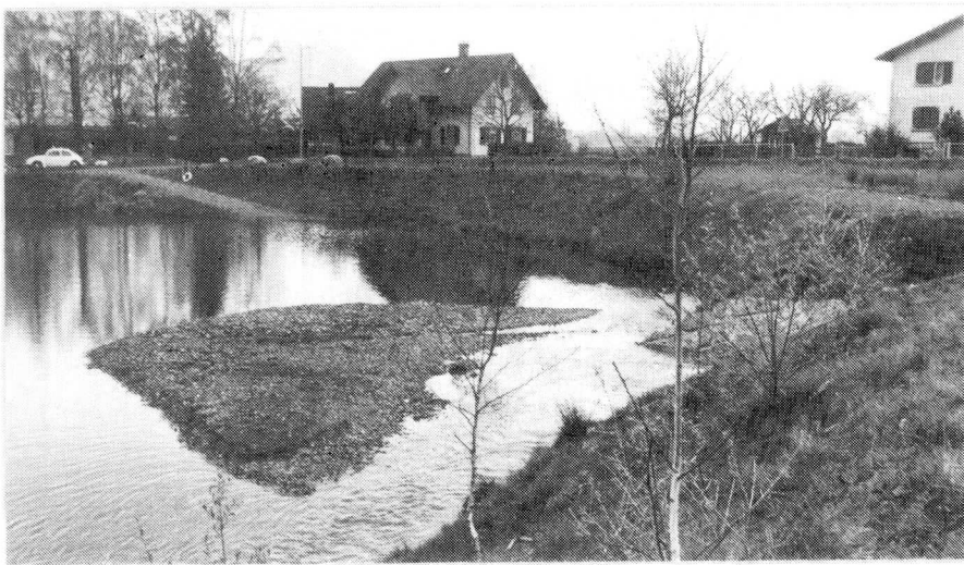
Bild 52 Kolkwall unterhalb des Einlaufes in den Ablagerungsplatz des Vilterser Baches bei Vilters. Er ist das Gegenstück zum oberhalb anschliessenden, jetzt wieder aufgefüllten Kolk des Einlaufwasserstrahles.
