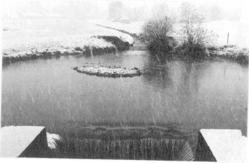
Bild 51 Kolkwall bis über die Wasseroberfläche im Chlausenbach bei Lauerz. Bleibt der Ablagerungsplatz wie in diesem Fall immer eingestaut, so präsentiert sich diese besondere Ablagerungsform als Insel.
