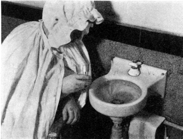
Abb. 92. Gurgel- und Spülbecken mit Wasserspülung
