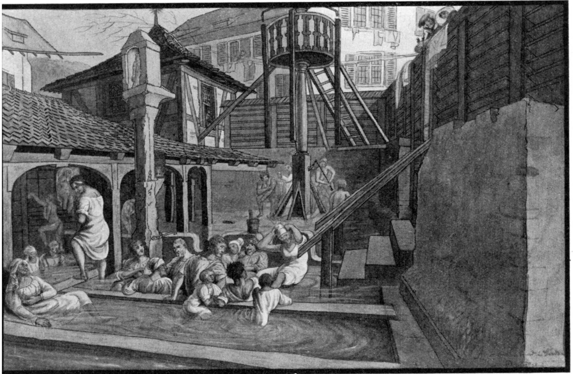
Abb. 54. Das Verenabad um 1820. Das Bad ist mit Jalousiewänden umgeben und teilweise überdacht. Auf einer Steinsäule die Statue der Hl. Verena. Im Hintergrund die Dusche mit Tropfkenneln und Pumpwerk
