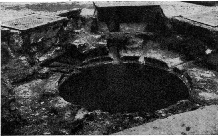
Abb. 38. Der alte Quellenkranz des Großen Heißen Steins mit dem Zulauf aus dem Kleinen Heißen Stein und den Verteilerrinnen der verschiedenen Anteilhaber
