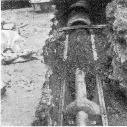
Abb. 46. Neue Thermalwasserleitungen: Zementschalen umgeben die Steinzeugrohre, der Zwischenraum ist mit Korkschnitz ausgefüllt. Die Muffen sind einbetoniert
