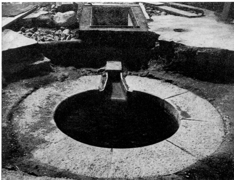
Abb. 40. Der neue Quellenkranz des Großen Heißen Steins. Es ist nur noch eine Abflußrinne angebracht, weil der Verteiler neben der Quelle angelegt wurde
